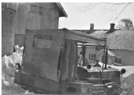
Snørydding på Vaule med bulldoseren 1955.
