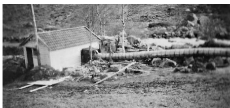
Kraftverket på Vaule bygd i 1940 for bnr. 1 og 3 i fellesskap. I drift til 1957. Turbinen kom fra Austrumdal.
