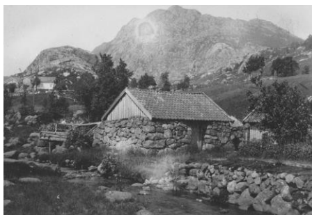
Tørkehuset med vasshjulet på venstre side som drog treskemaskinen på lensmannsgarden. Snora gikk i bein linje forbi lensmannshuset og inn på låven. Under treskinga stengte de vegen for omkjøring forbi Petter-garden.
