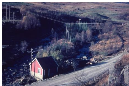
Kraftverket ved Skjævelandsåna. Foto: Per Espedal.
