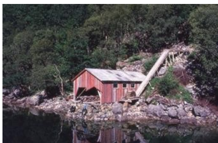
I Dyrskog var det eigen tømmerkog. Her er bilete av den nye saga etter som den gamle saga brann opp. Dette var ei oppgangssag som blei driven av vasskraft.
