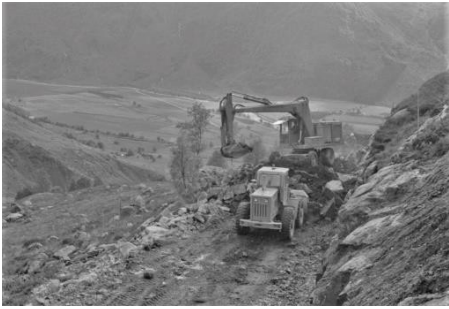
Vegarbeid med Ørsdalsvegen øverst i Eikbrekka.
