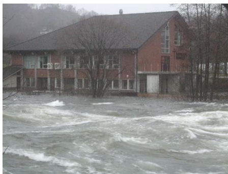
Store vannskader i underetasjen på bedehuset.
