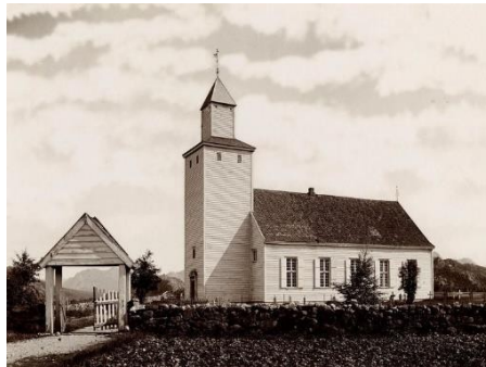
Bjerkreimskirken bygget i 1835.
