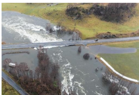
Bjerkreimsbrua over E39.
