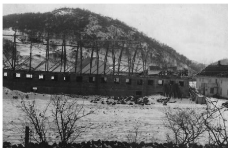
Den nye fjøsbygningen til Klaus (K.G.M.) Bjerkreim reist i 1954. Foto: Alf Gjødrem, han tok et foto fra samme vinkel for hvert sperr som ble reist.
