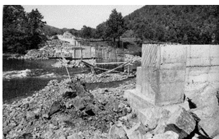
Bjerkreimbrua over Gjerdakleiva bygget i 1975.
